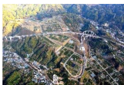
庵原地域の樹園地造成
