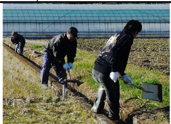
水路の泥上げ
