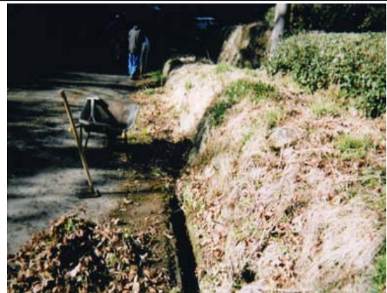
側溝の泥上げ
