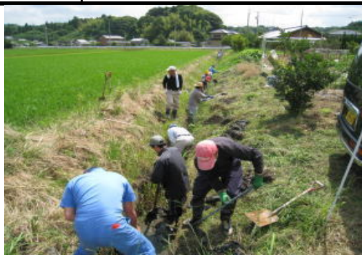
農業用水路の泥上げ
