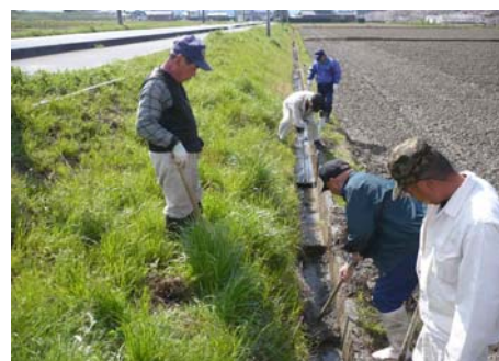
水路の泥上げ
