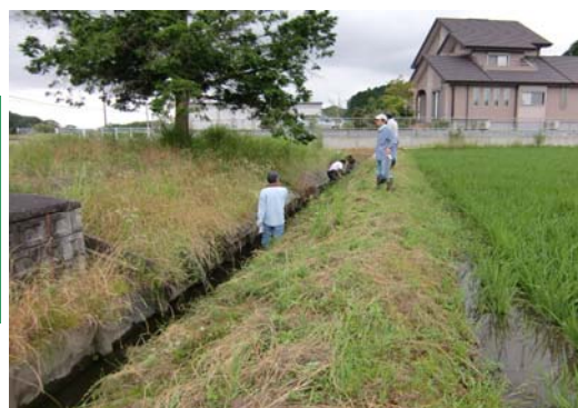
水路の泥上げ
