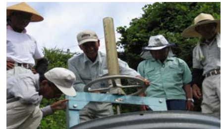
パイプライン(施設の点検)
