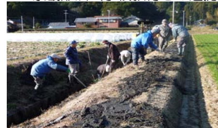
開水路(水路法面の初期補修)
