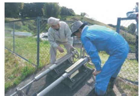
ゲートの保守点検
