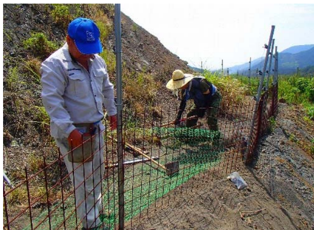
施設の点検・補修の様子
