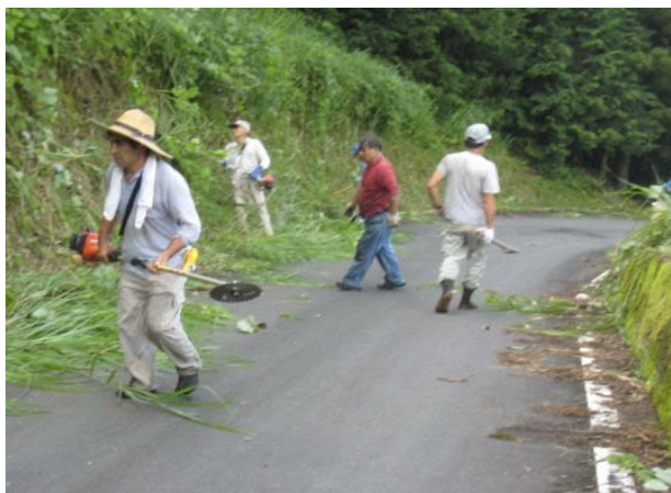
農道の路肩法面の草刈り
