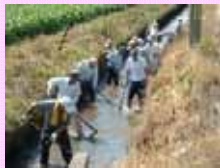
水路の泥上げ
