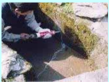
水路のひび割れ補修
