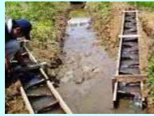
水田魚道の設置
