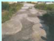
農道の窪みの補修
