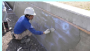
老朽化した水路壁のコーティング
