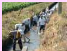
水路の泥上げ
