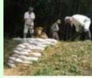
漏水箇所の補修
