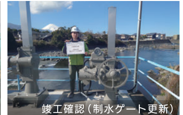
竣工確認(制水ゲート更新)
