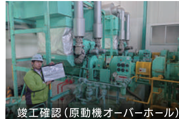
竣工確認(原動機オーバーホール)
